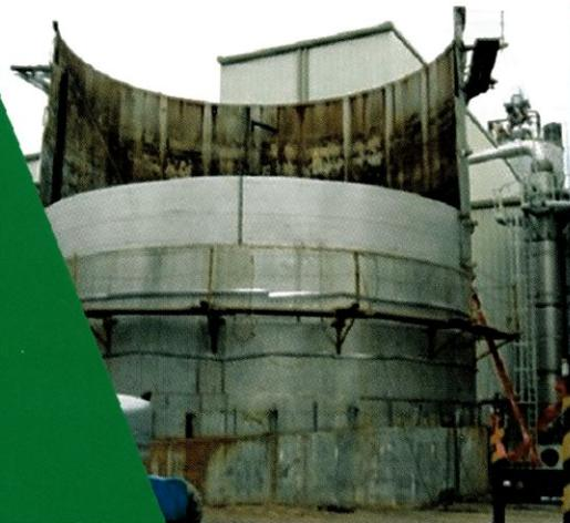
**PASA-GARD SFW** پوشش دو جزئی بر پایه سیمان و اکرلیک با نسبت ۲ به ۱ می باشد. از مزایای این پوشش می توان به بدون تاثیر در کیفیت آب شرب، سرد اجرا، بدون درز، انعطاف پذیری بالا، ایجاد پل بر روی ترک ها، دوام بالا، مقاومت در برابر سولفات و کلر، چسبندگی بالا، امکان اجرا بر روی بلوك و آجر، بتون، کاشی و سرامیک امکان اجرای کاشی و سرامیک بر روی آن، امکان رنگ آمیزی و تحمل دما تا ۸۰ درجه اشاره کرد. میزان مصرف ۲ کیلوگرم در متر مربع در دولایه به همراه یک لایه مش فایبرگلاس می باشد.
